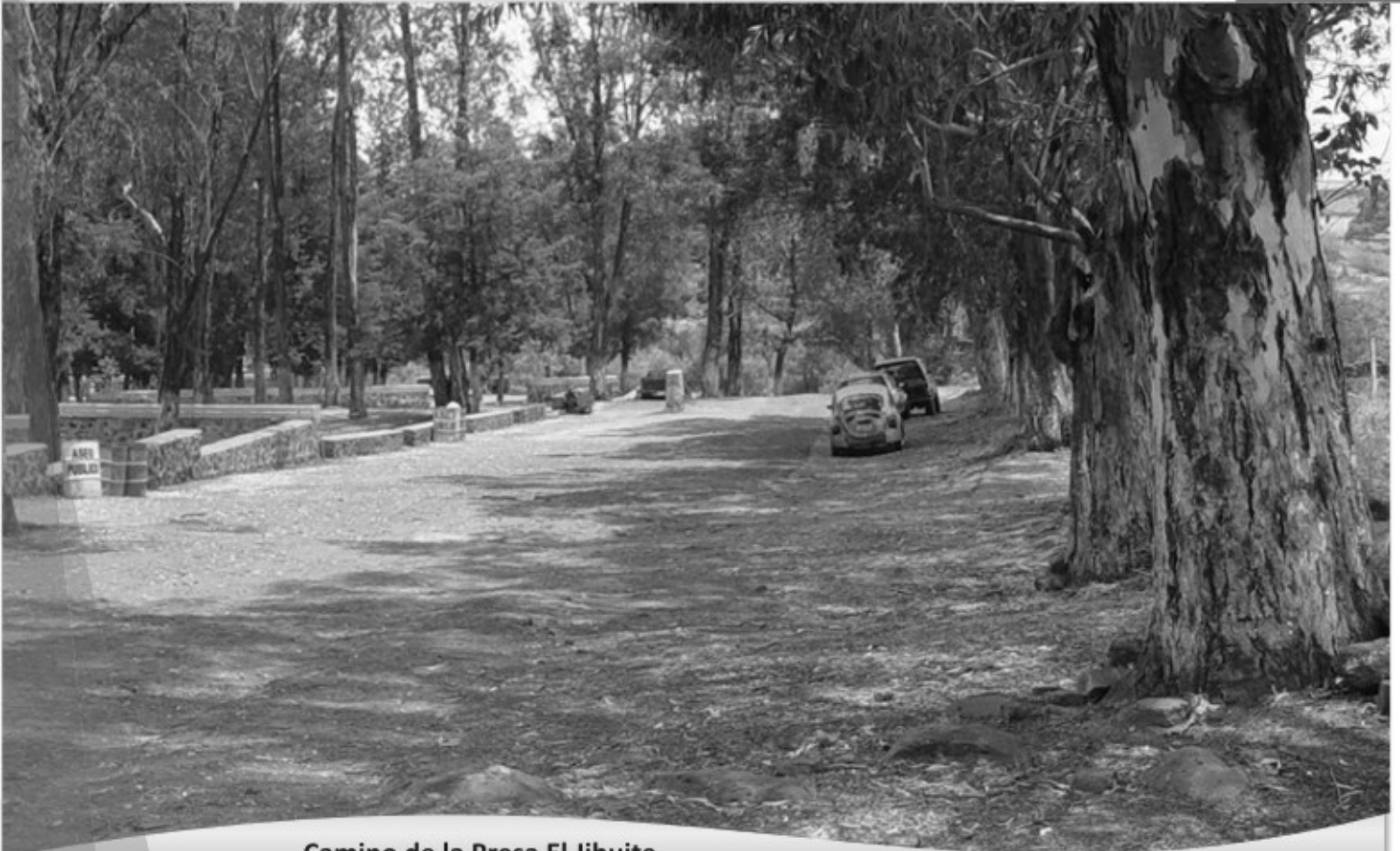
Camino de la Presa El Jihuite
